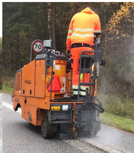
Figur 8.6 Eksempler på metoder til skånsom fræsning af kørebaneafmærkning med vandspulefræser og valsefræser.
