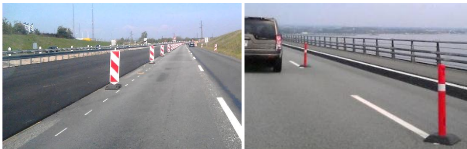
Figur 6.18 Eksempler på længdeafspærring mellem arbejdsområde og kørebane.
