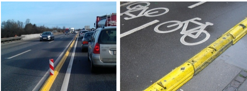
Figur 7.28 Eksempler på anvendelse af ledebjælke.
