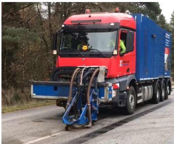
Figur 8.6 Eksempler på metoder til skånsom fræsning af kørebaneafmærkning med vandspulefræser og valsefræser.
